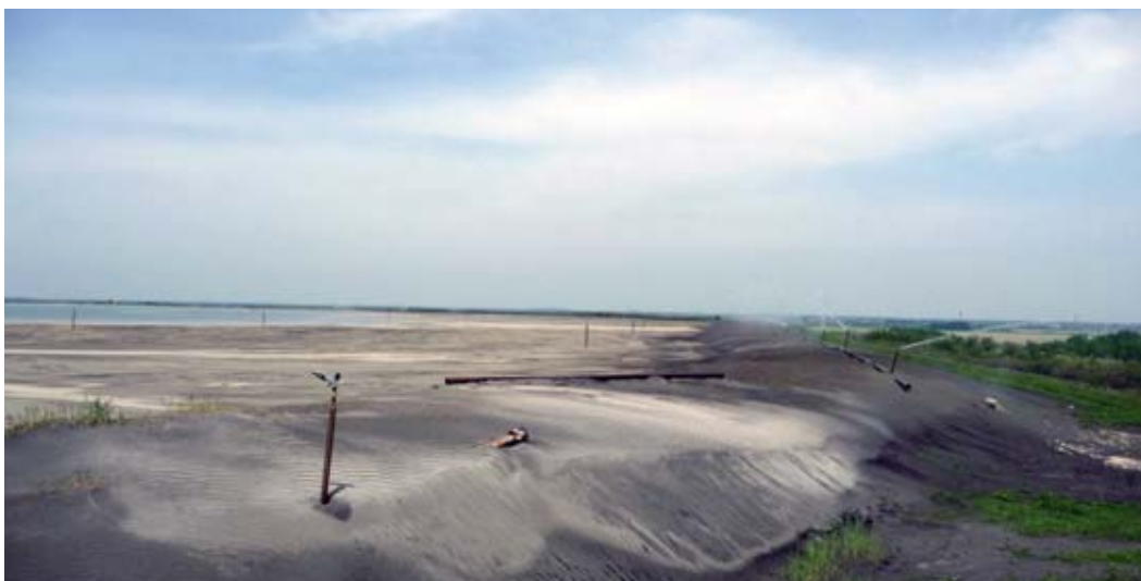
KUDA IDE PEPEO: Deponija sa prskalicama; rekonstrukcija elektrofiltra na bloku 6 TENT-a A
