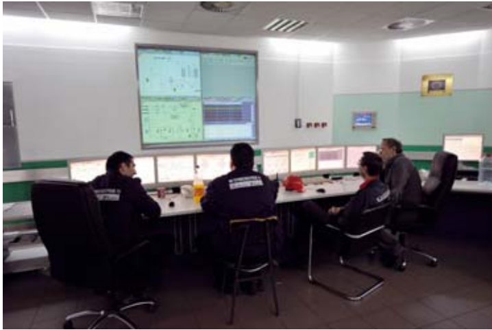
...kontrolna soba i generator na jednom od šest blokova
